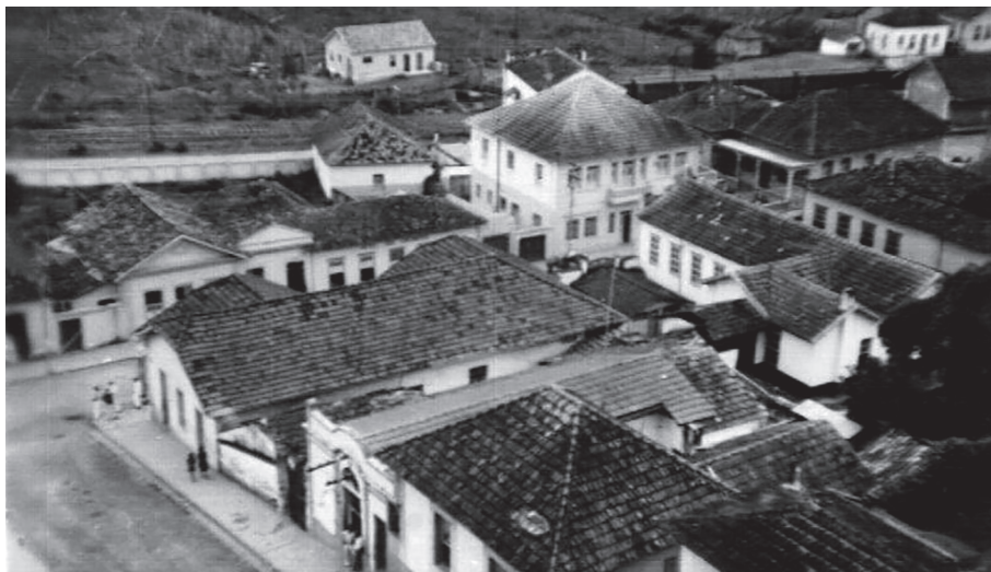
“De frente vê-se claramente o Hotel dos Viajantes, de Dona Maria Rosa, minha avó paterna.” “Foto tirada do alto da torre da Igreja, em 1946”. Por Emmanuel Peralta no Grupo Maria da Fé Antiga.
