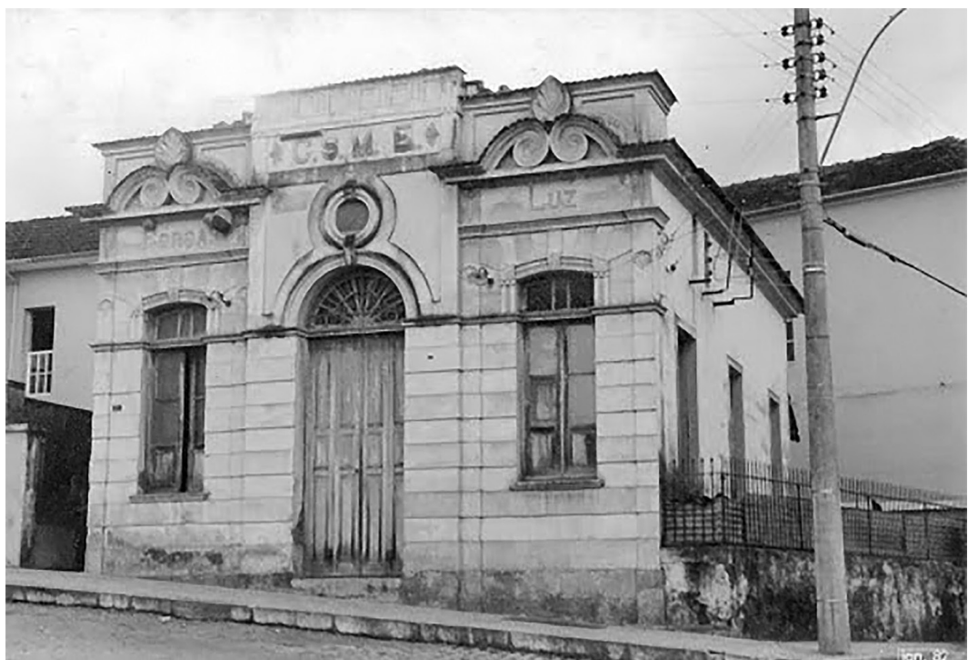
Prédio da Companhia Sul Mineira de Eletricidade - “Força e Luz” que chegou ao município em 1925 - Acervo de Rubia Daher. Foto publicada no Grupo Maria da Fé Antiga - Cidade que amamos! - Facebook.
