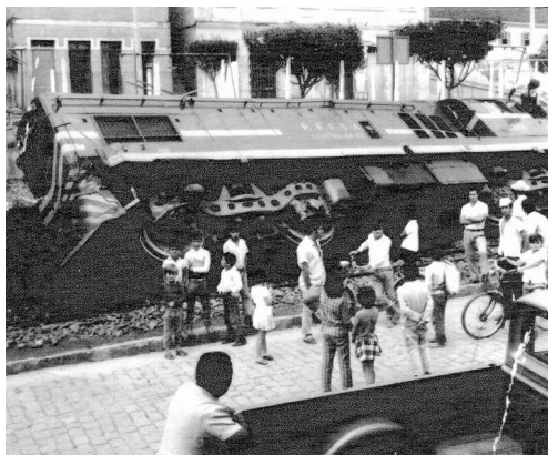
Descarrilhamento do trem no centro de Maria da Fé (s/d) - acervo: Elaine Freitas
