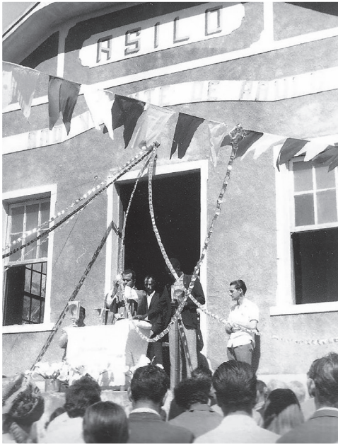
Construção do Lar São Vicente de Paula, no lugar do Asilo São Vicente.
