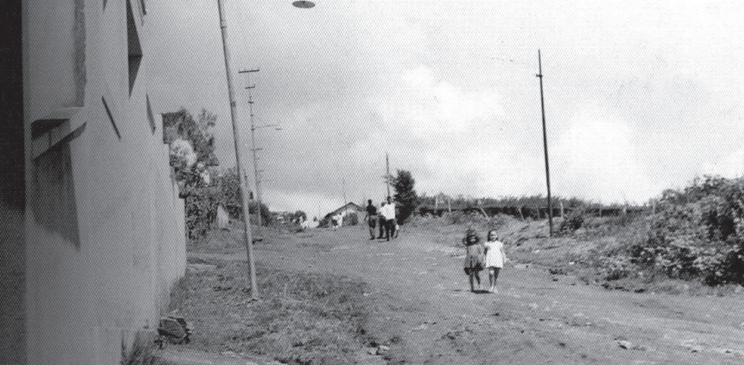
À direita da Rua João Gonçalves da Costa – local onde estava situada a Chácara de Braz Maria Junho, bem em frente à subida para o cemitério. Acervo de Joaquim Santana de Almeida (Quim).
